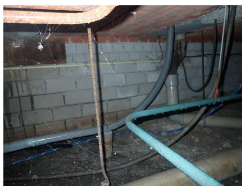
Foto 12: overzicht kruipruimte. Zichtbare riolering van PVC. Geen asbestverdachte materialen waargenomen.
