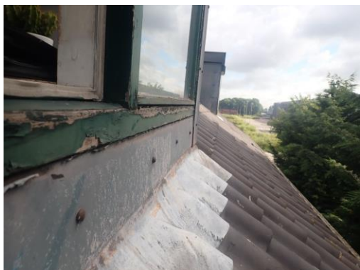
Foto 1: overzicht niet asbestverdachte aftimmering ter plaatse van de dakkapel.
