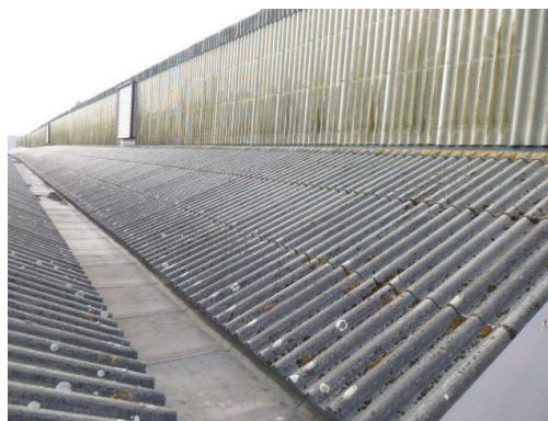
Foto 14: de verticale dakdelen bestaan grotendeels uit polyester golfplaten.
