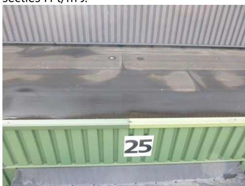
Foto 17: platte dak met bitumen dakbedekking van het loadingdock van secties N/O.
