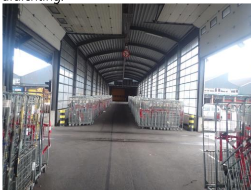
Foto 23: deze nieuwe corridor is van veel later bouwwerk en is in zijn geheel als niet-asbestverdacht te beoordelen.
