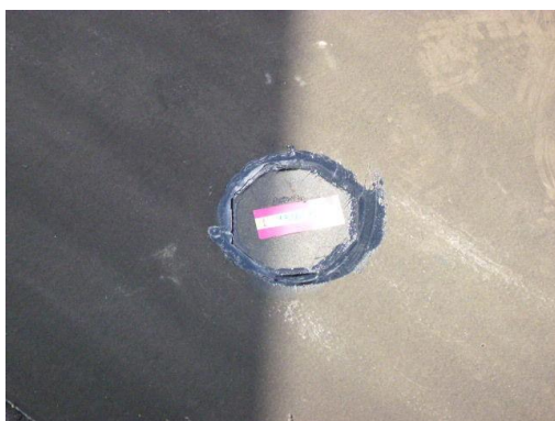
Foto 21: alle gaten in de bitumen dakbedekking zijn na bemonstering of inspectie afgedicht. Dit is een tijdelijke afdichting.
