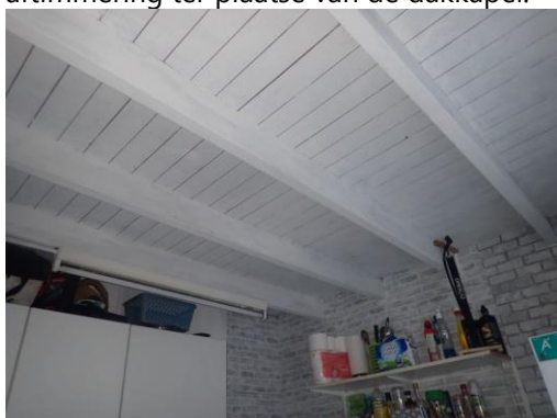
Foto 3: overzicht houten dakconstructie ter plaatse van de aanbouw/berging.
