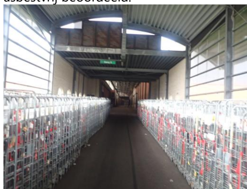
Foto 22: staande in de nieuwe corridor (het terrein overstekend tussen N en H) kijkende naar de corridor langs sectie N (onderdeel uitmakend van de veilinghallen).
