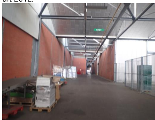
Foto 10: transportgang tussen secties L en M1.
