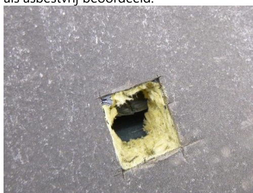
Foto 18: zie foto 17, de bitumen dakbedekking bemonsterd als M7 en M8 en als asbestvrij beoordeeld.
