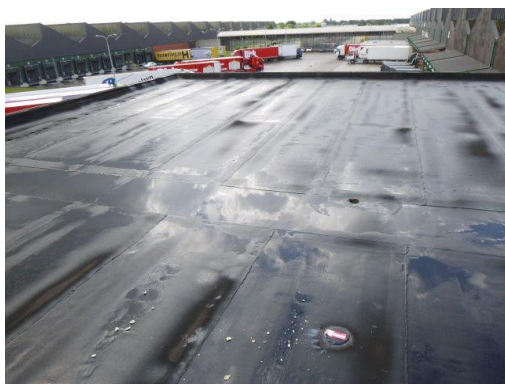
Foto 14: platte dak van het kantoorpand (J).
