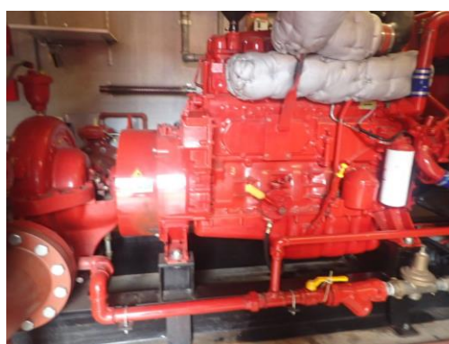
Foto 6: De grote brandbluspomp van het merk Scania met als bouwjaar 1993.
