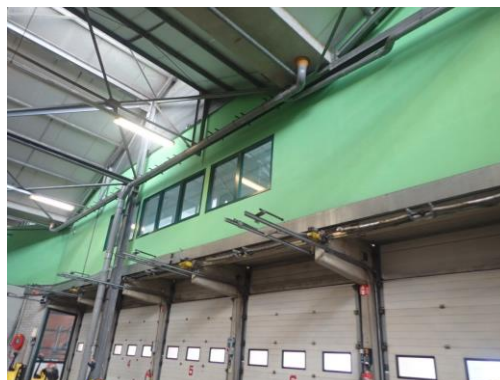
Foto 2: op meerdere plaatsen boven de loadingdocks een entresol waarin kantoren of andere personeelsvoorzieningen zijn ondergebracht.
