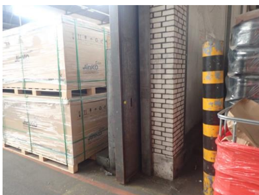
Foto 5: verzinkt stalen branddeuren tussen secties O en N.
