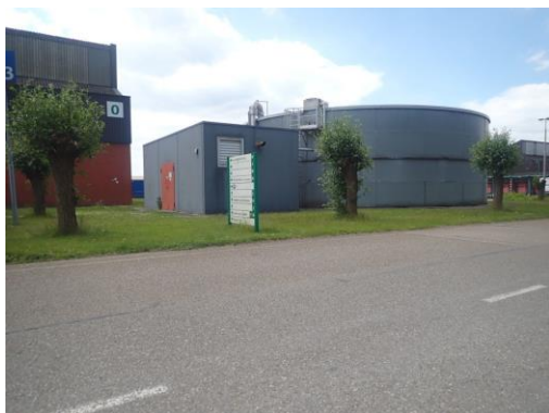
Foto 1: betonnen gebouw met daarin opgesteld de diesel aangedreven brandbluspompen, daarachter een bluswater voorraadtank.
