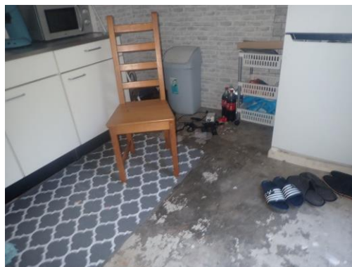
Foto 2: overzicht van de kale betonvloer in de aanbouw/berging.
