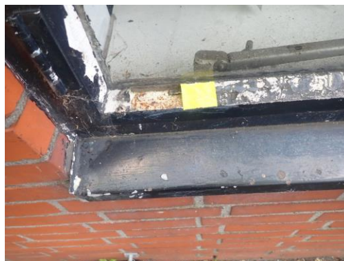
Foto 2: zie foto 1, stopverf bemonsterd als M7 en M8 en als asbestvrij beoordeeld.
