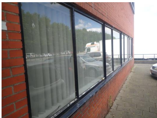
Foto 1: sectie G een stalen raampartij met oude stopverf.
