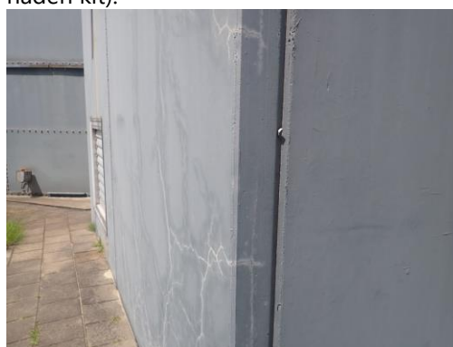
Foto 4: gebouw bestaat uit prefab betonnen elementen.
