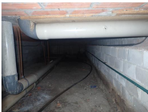
Foto 13: overzicht kruipruimte. Zichtbare riolering van PVC. Geen asbestverdachte materialen waargenomen.
