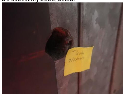
Foto 6: zie foto 5. brandwerende isolatie achter de stalen platen bemonsterd als M11 en als asbestvrij beoordeeld.
