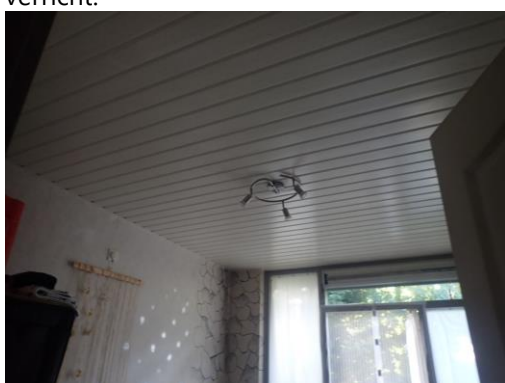
Foto 11: overzicht vast verlaagd plafond, houten schroten. Geen destructief onderzoek verricht.
