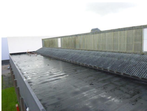
Foto 19: platte dak met bitumen dakbedekking van het loadingdock van secties R t/m T.
