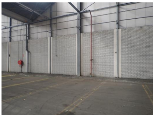
Foto 7: muur tussen secties O en R, stroken board langs de stalen kolommen.
