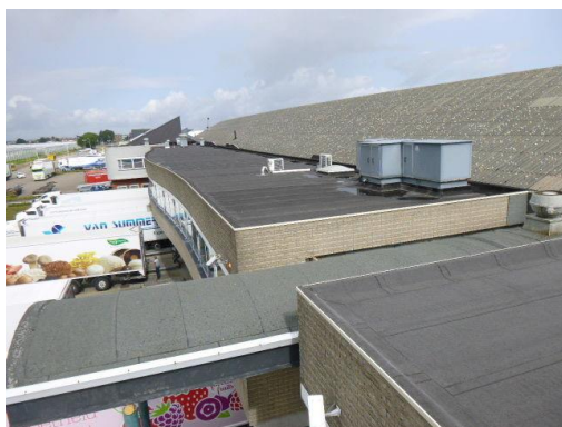
Foto 19: de platte daken boven het loadingdock/kantoren van secties M1/M2.
