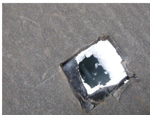
Foto 18: zie fot 17. De bitumen dakbedekking bemonsterd als M18 en M19 en als asbestvrij beoordeeld.
