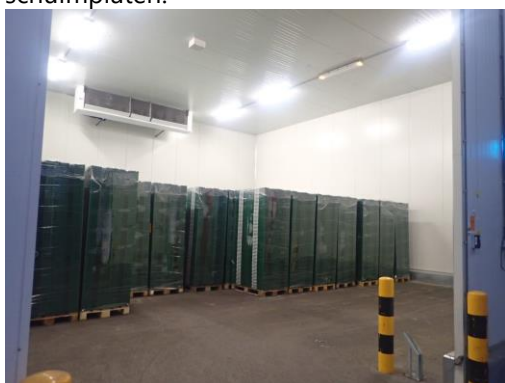
Foto 11: voormalige koelcellen gemaakt van prefab metalen sandwichpanelen (kunststof coating en kern van PU-schuim). Dezelfde panelen zijn ook gebruikt om wanden en muren op andere plaatsen te maken.
