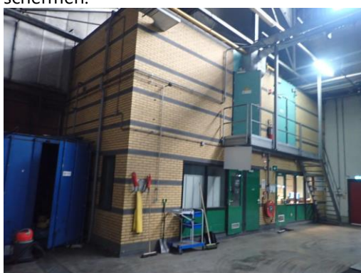
Foto 11: sectie R. Gebouw met kantoor/werkplaats op de begane grond en technische ruimten op de verdieping.
