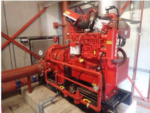
Foto 7: de kleine brandbluspomp van het merk John Deere met als bouwjaar 1993.
