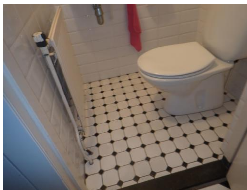
Foto 8: overzicht vaste vloerafwerking, plavuizen. Geen destructief onderzoek verricht.
