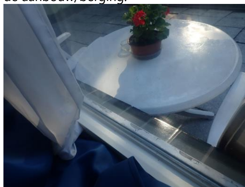
Foto 4: overzicht raamkozijn. Oppervlakkige kit betreft siliconen. Keramische waterslagen.
