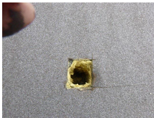
Foto 20: zie foto 19, de bitumen dakbedekking is bemonsterd als M9 en M10 en als asbestvrij beoordeeld.
