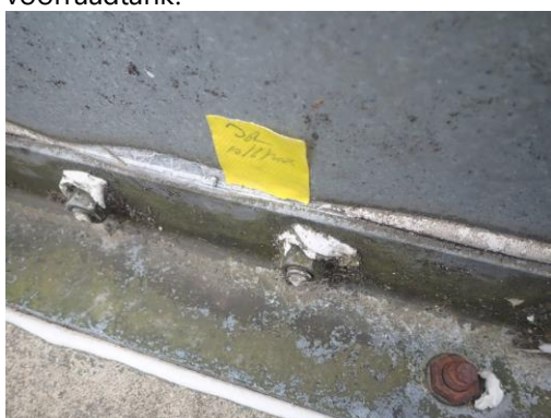
Foto 3: zie foto 2, de kit in de naden is bemonsterd als M1 en M2 en als asbestvrij beoordeeld.
