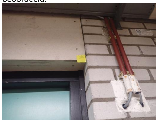
Foto 12: zie foto 11. Brandwerend board boven de deuren en de plafonds van de technische ruimten bemonsterd als M14 en als asbestvrij beoordeeld.
