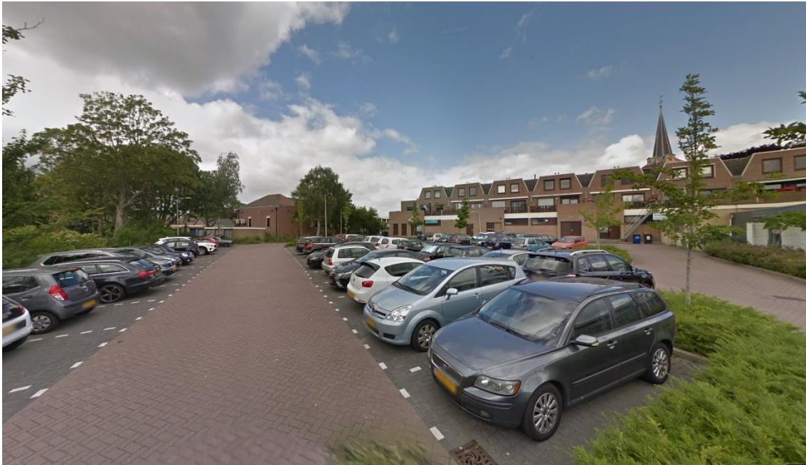
Afbeelding 2.4: Bestaande situatie van het parkeerterrein aan de Terpstraat, gezien in noordwestelijke richting (bron: Google Maps).
