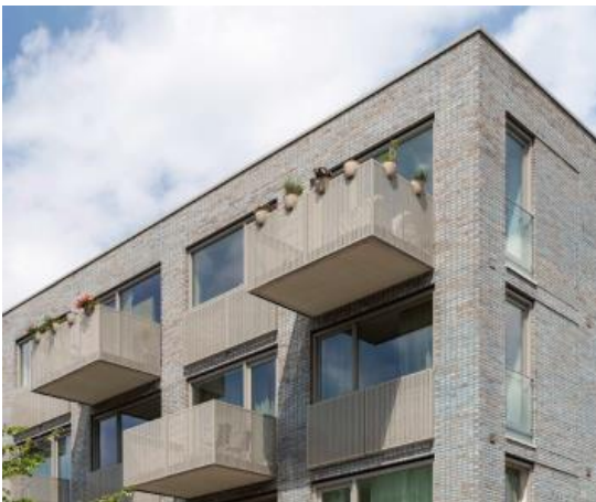
Balkons zijn qua positionering, materiaal en detaillering afgestemd op het gevelontwerp (project Kostverloren Groningen)
