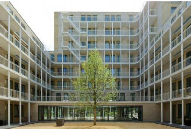
Referentie galerijen binnenterrein (project Square Amsterdam)
