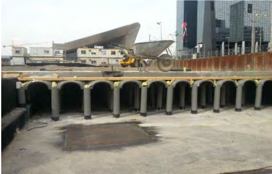
Afbeelding 4.13 Watershells op parkeergarage voor Centraal Station Rotterdam
