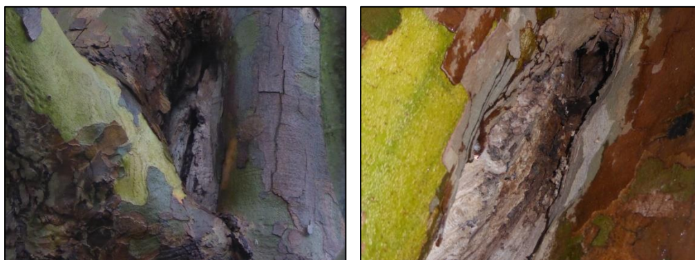
In de aangetroffen holtes in de boom kunnen verblijfplaatsen van boombewonende vleermuizen aanwezig zijn.
