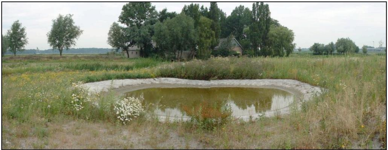
Figuur 2. Schotelvormige betonnen poel voor rugstreeppadden naar Engels ontwerp zoals toegepast in de Boekelermeer te Alkmaar.
