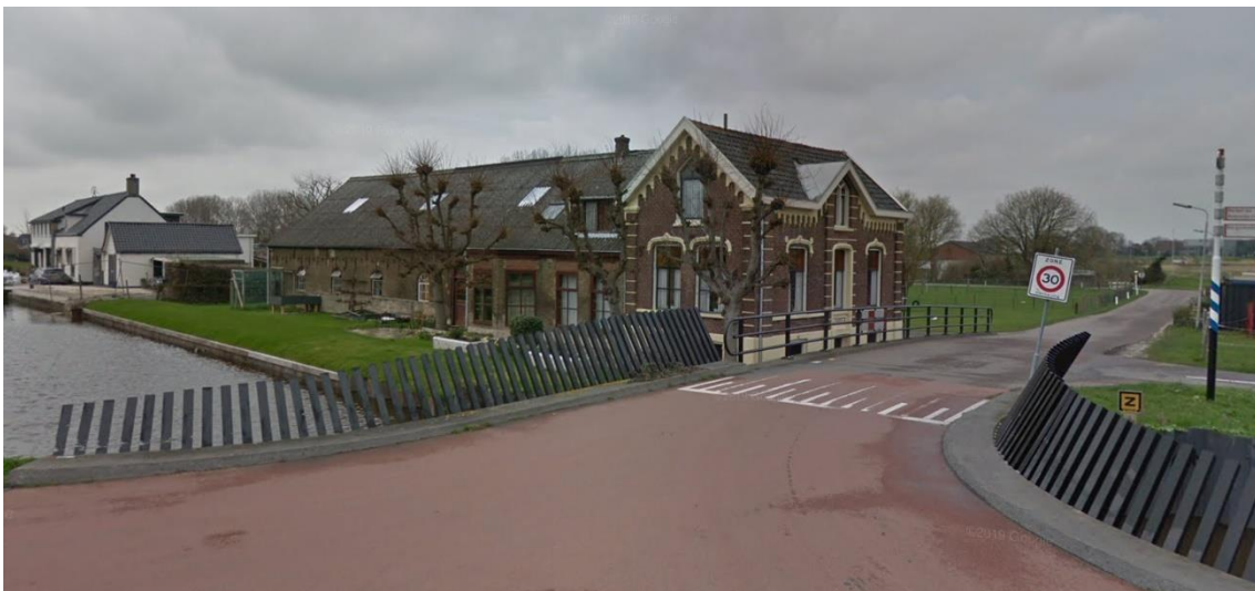
Afbeelding 2.1: bestaande situatie plangebied (bron: Google Streetview, maart 2019).
