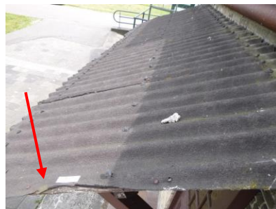
foto: dakbedekking (MM5)
