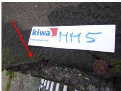
foto: dakbedekking (MM5)
