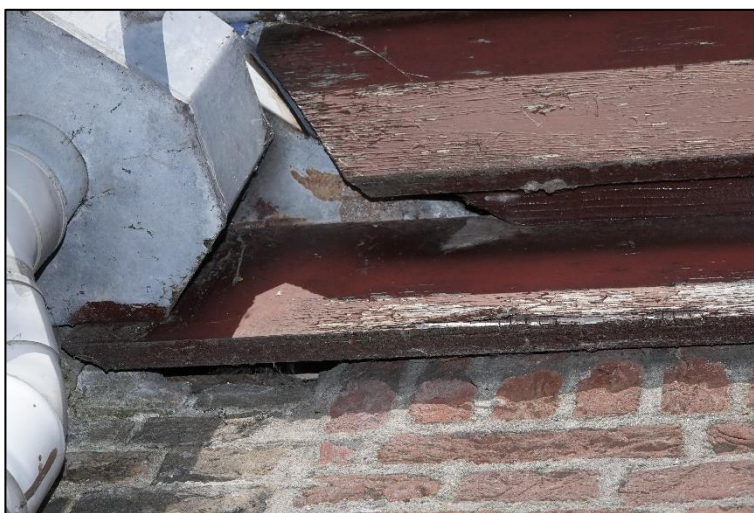
Ruimte tussen de muur en houtbetimmering aan de zuidzijde van het bijgebouw.
