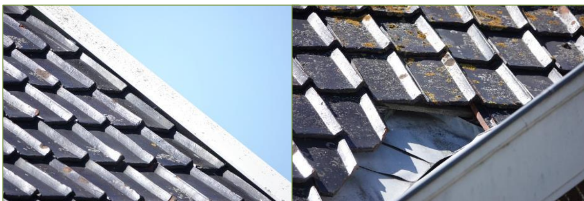
Ruimte onder dakpannen en tussen houten betimmering en dakpannen waaronder vleermuizen, Gierzwaluwen en Huismussen kunnen wegkruipen.
