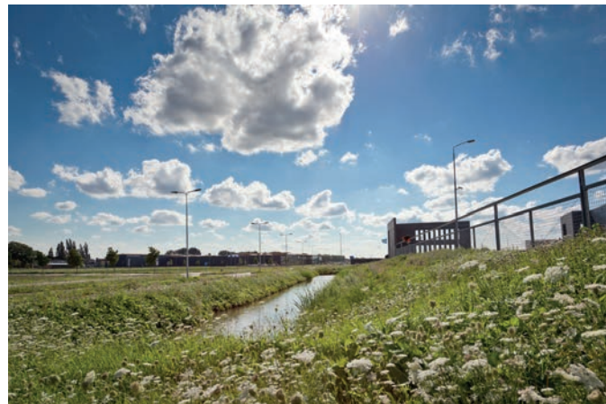
De steilrand in fase 1
