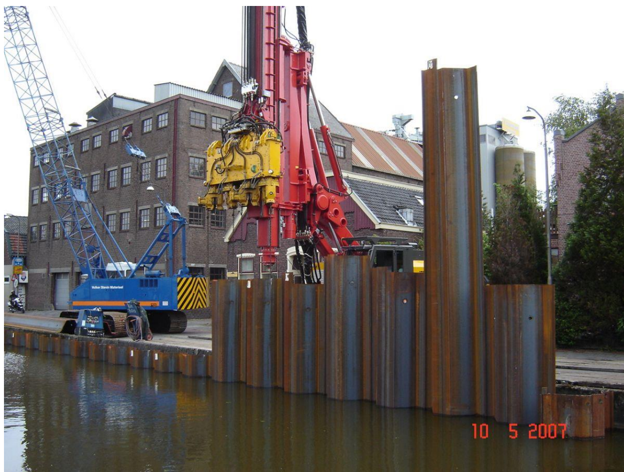
Figuur 14 Trillingsvrij aanbrengen van de damwand met maalderij Treurniet op de achtergrond (bron: https://www.vsf.nl )
