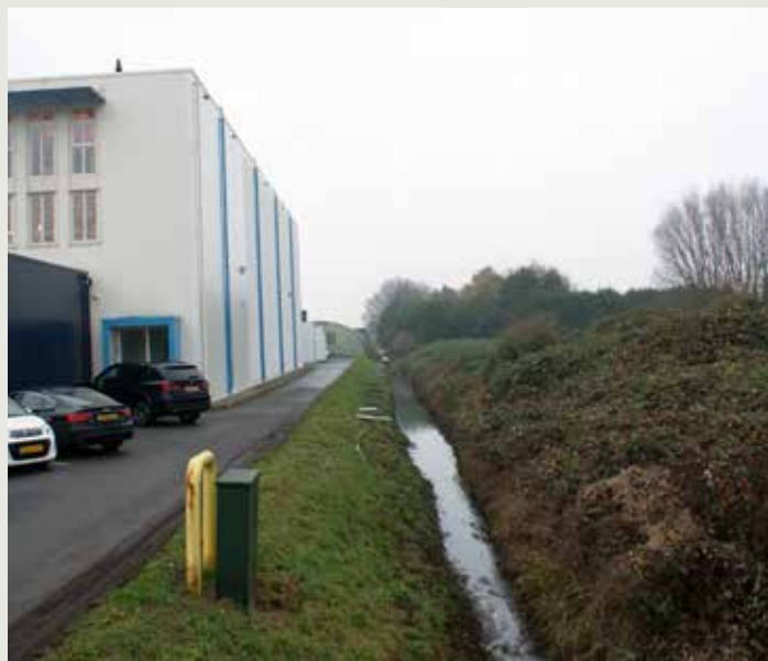
Sloot tussen Hoekeindseweg 119 en De Jong Diepvries BV
