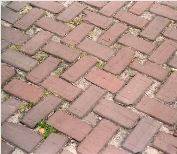
Referentie hergebruik verharding in open bestratingsverband
