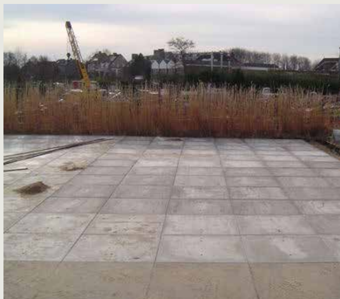
Referentie hergebruik bedrijfsploerplaten
