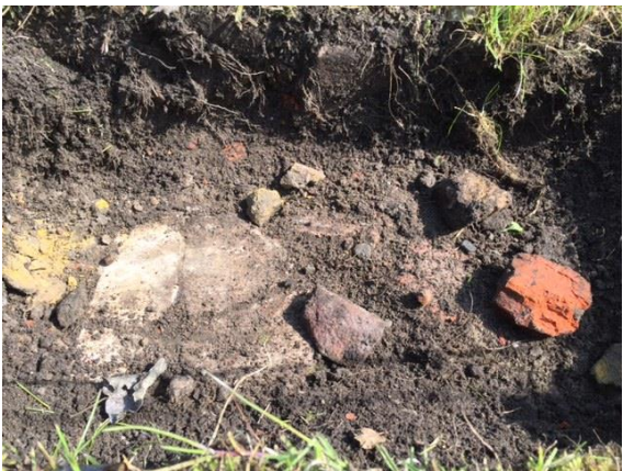
Foto 5: Puinfunderingslaag onder de klinkerverharding
