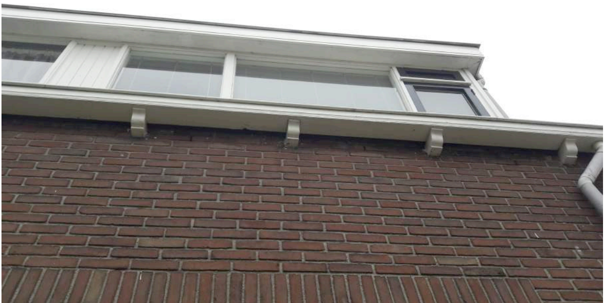
Voorzijde van de bebouwing binnen het plangebied met ruimte tussen de dakgoot en de muur. Hier zijn sporen van vogels aangetroffen.
