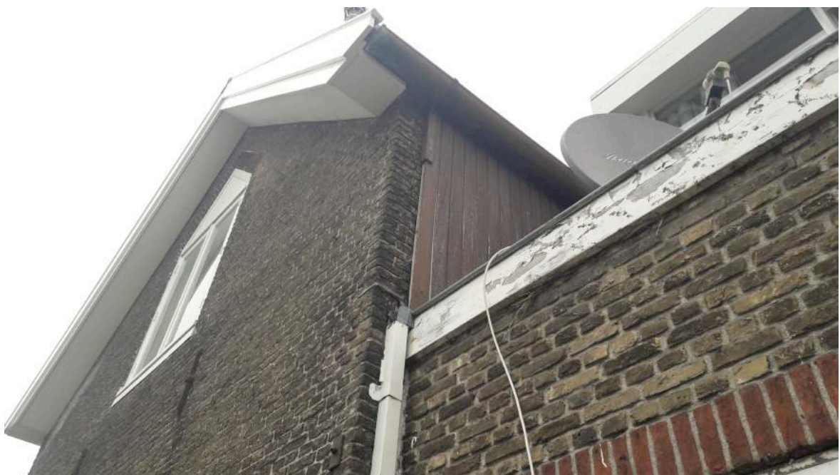
Spleten tussen muur en dak geschikt voor vleermuizen en vogels.
