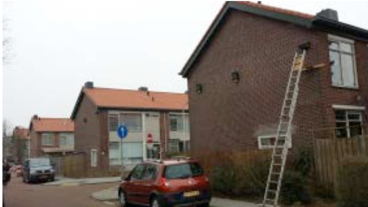
Afbeelding 2: Gierzwaluwkasten en vleermuiskasten, opgehangen aan de Luytenstraat 1 en 2, Ruyterstraat 1 en 2
