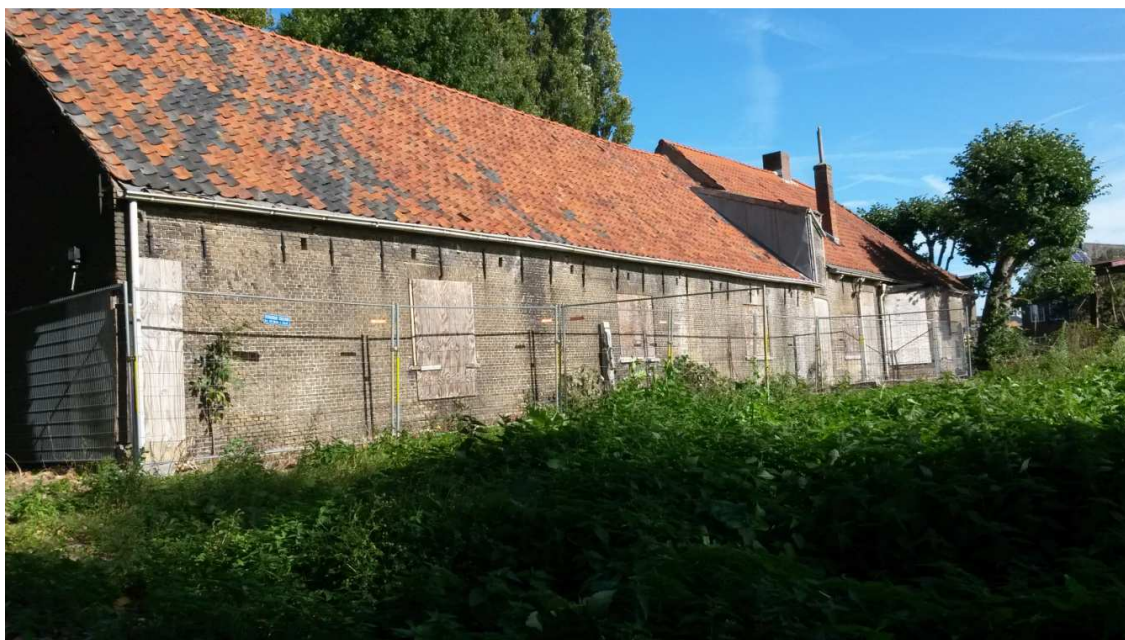
Afbeelding 10 Foto van de boerderij (richting het noordoosten), genomen tijdens het veldwerk. Bron: foto Vestigia (28-9-2016).
