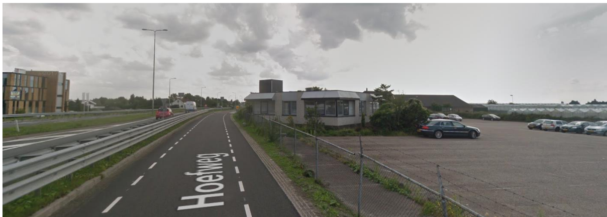
Huidige kantoorgebouwtje langs de N209
