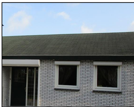
Foto 6: Dak van bitumen plaatjes
