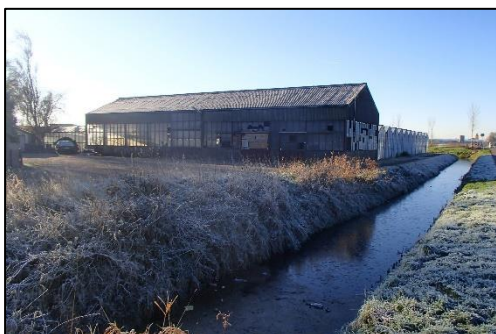
Overzicht plangebied vanuit het noorden.
