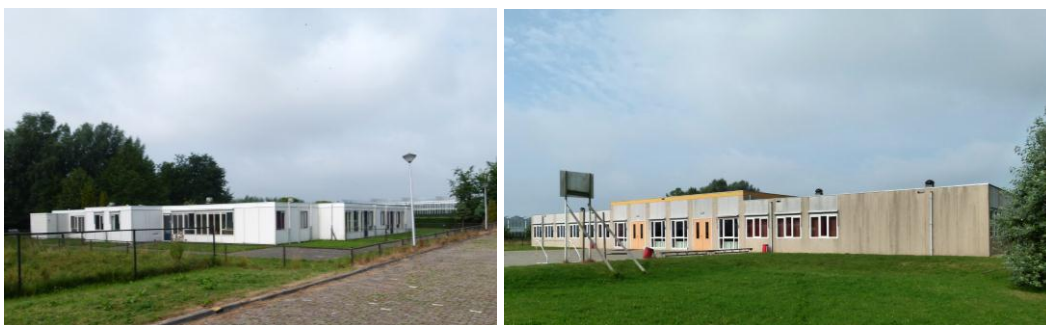
Foto 1 en 2: De te slopen bebouwing is, vanwege de afwezigheid van spouwmuren en -gaten en andere openingen die als mogelijke invliegopening voor vleermuizen zouden kunnen dienen, niet geschikt als vleermuisverblijfplaats (door Ronald van Jeveren).
