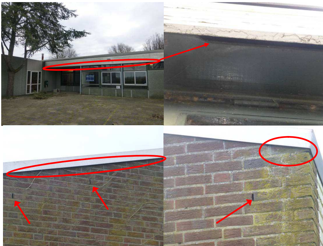
Afbeelding 5.3. Voorbeeld van de aanwezige ruimtes en open spouwmuurgaten in het plangebied. Deze zijn in potentie geschikt als vaste rust- en verblijfplaats voor vleermuizen en/of geven toegang tot vaste rust- en verblijfplaats in het gebouw.
