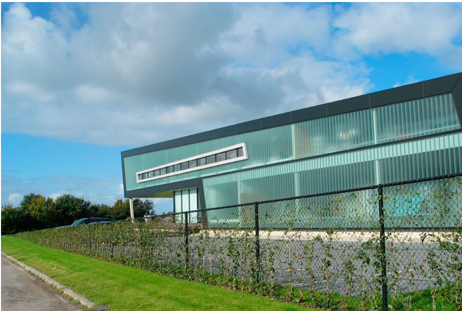
middels een semi transparante gevel ontstaat een aantrekkelijke en dynamische gevel
