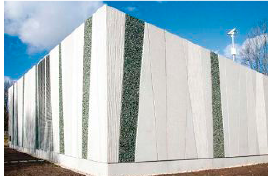
duidelijk herkenbaar hoofdvolume, middels de toepassing van meerdere gelijkwaardige texturen ontstaat een aantrekkelijke en dynamische gevel
