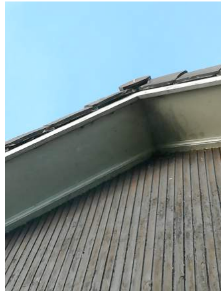
Afbeelding 7: woonhuis aan de straatkant. Openingen onder dakpannen. Geschikt voor vleermuizen Foto: M. Oomen, Ecoresult B.V.
