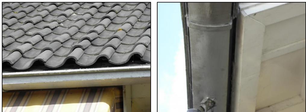
Openingen die door huismussen en gierzwaluwen als verblijfplaats kunnen worden gebruikt.
