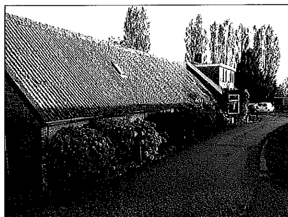
Foto 6: Woning, schuur en toegangsweg
