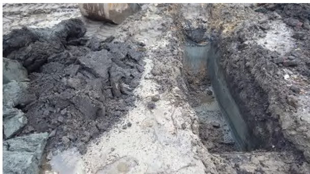
Sleuf sl12: Foto 2
