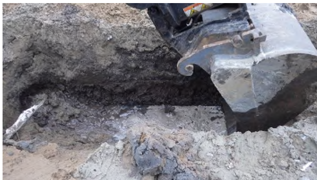
Sleuf sl03: Foto 1
