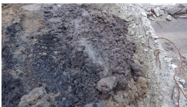
Sleuf sl03: Foto 2
