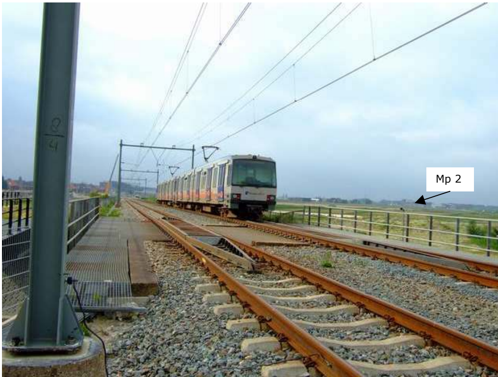
Foto 1: SG 2 ter hoogte van stalen brug
