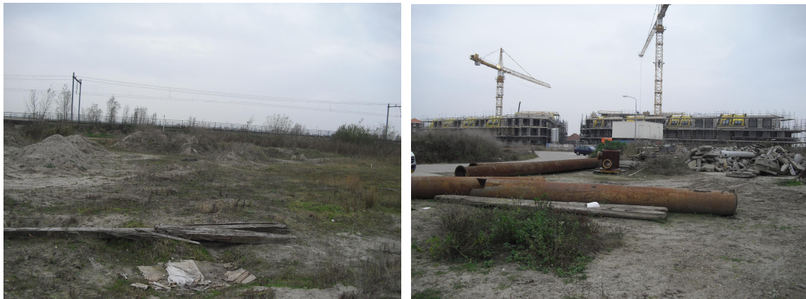
Figuur 2.1: Foto's terreininspectie 5 december 2014: voorbelasting en opslag puin.
