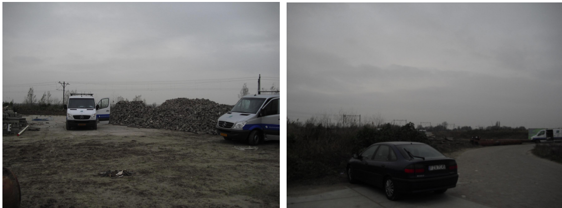
Figuur 2.2: Foto's terreininspectie 5 december 2014: voorbelasting en opslag klinkers en bouwweg met klinkers en betonplaten.
