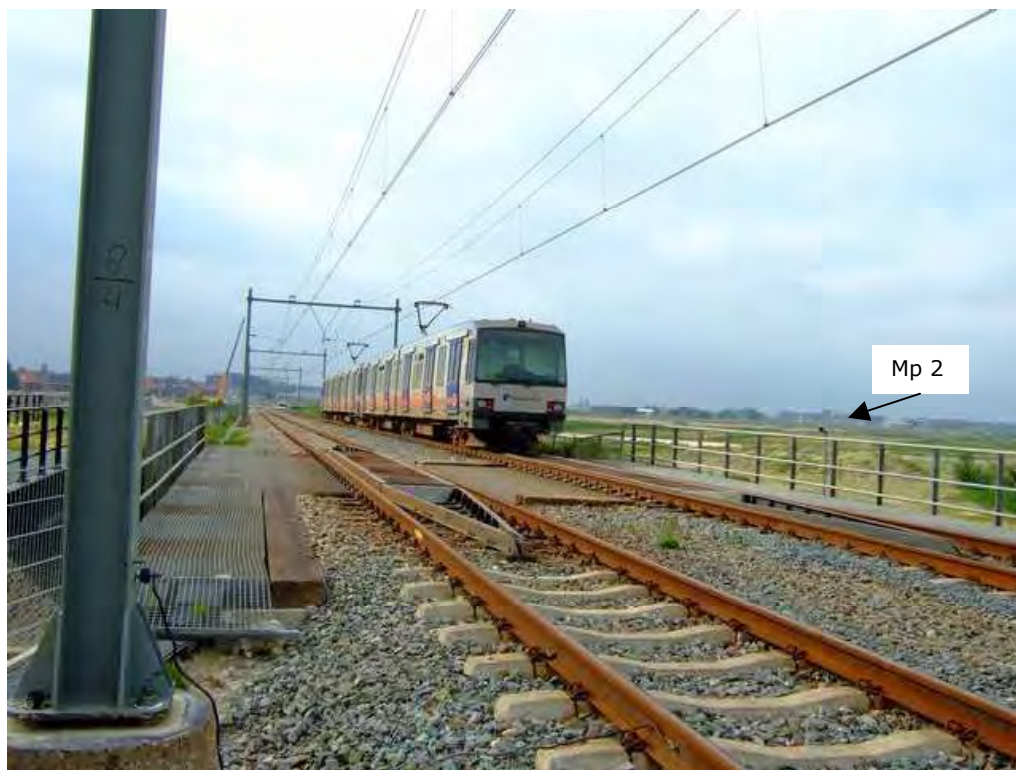
Foto 1: SG 2 ter hoogte van stalen brug
