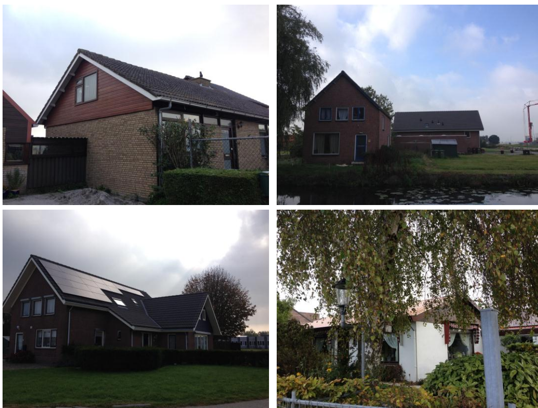
Foto 1 t/m 4: De te handhaven bestaande woonhuizen die, vanwege de aanwezigheid van spouwmuren en -gaten en andere openingen die als mogelijke invliegopening voor vleermuizen zouden kunnen dienen, potentieel geschikt zijn als vleermuisverblijfplaats (door Margot Vervoort).
