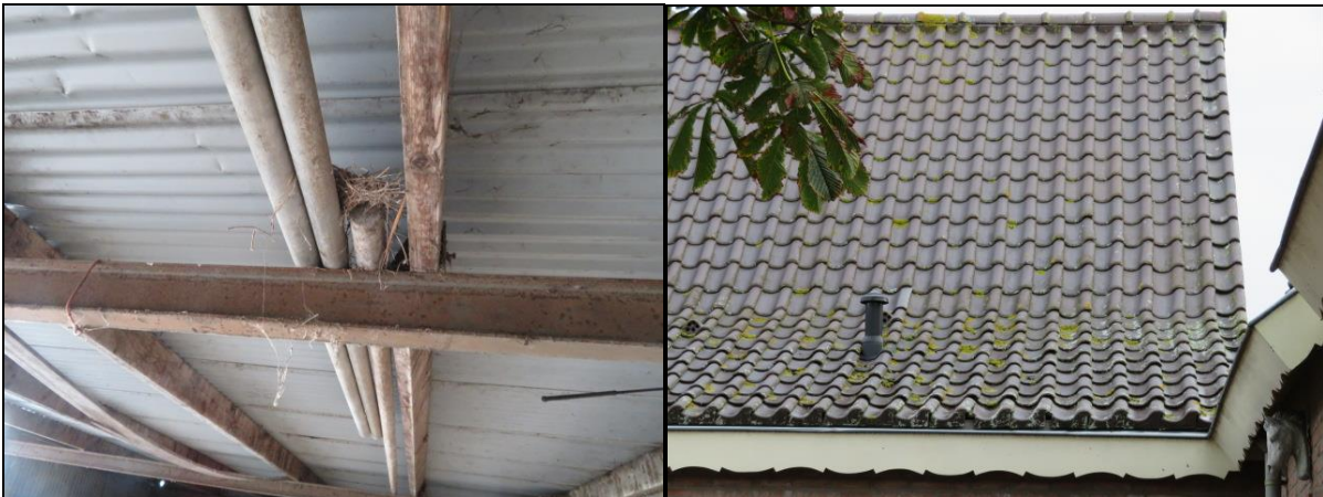
Foto 2: stal/schuur dak van plaatstaal met nestje
