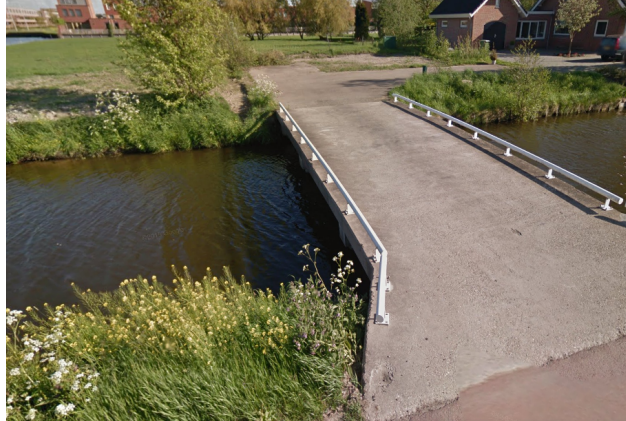
referentie lage brug met reling
