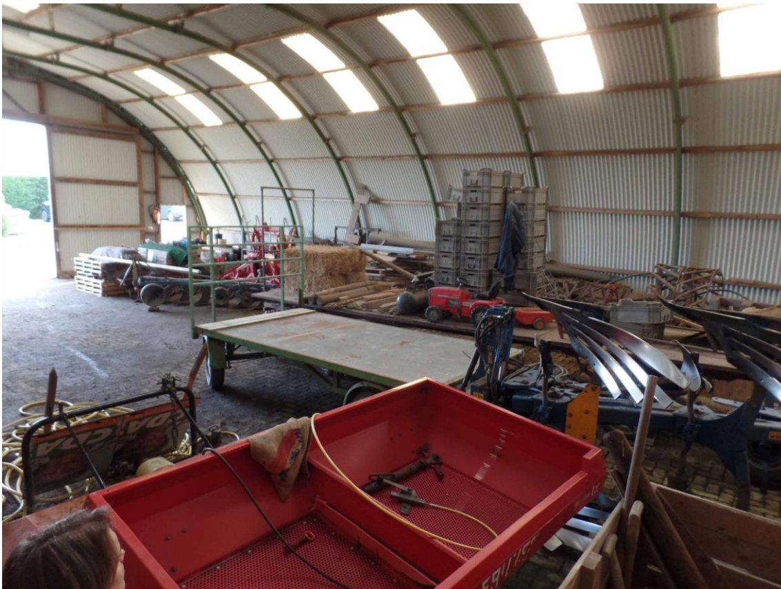
Figuur 2: Binnenzijde van de af te breken Romneyloods
