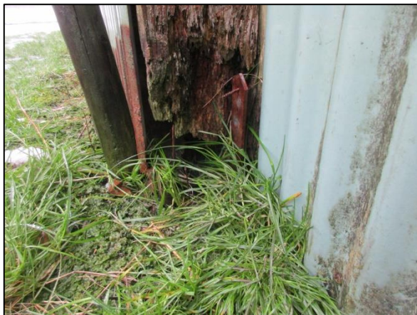
Foto 5: Opening aan de noordzijde
