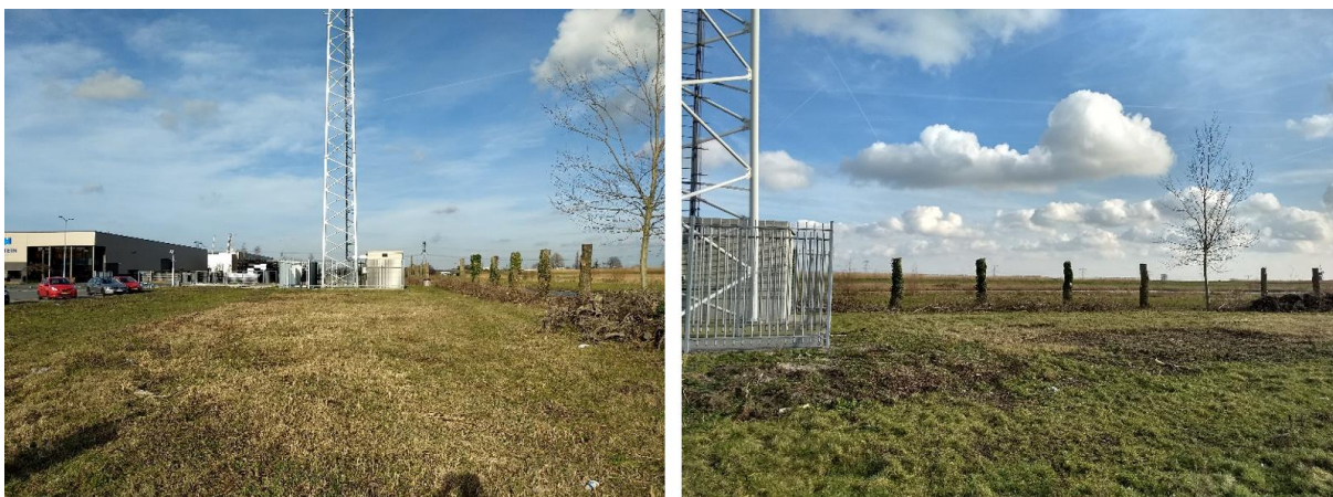
Afbeelding 3 & 4. Impressie plangebied in de richting noordoost (links) en in de richting zuidwest (rechts). Bron: veldinspectie 12 februari 2019.
