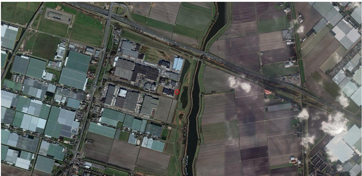
Afbeelding 1. Ligging plangebied waar het pompstation (rood omcirkeld) wordt gerealiseerd.
