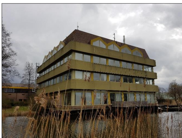
Figuur 3. Kantoorgebouw in westen plangebied
