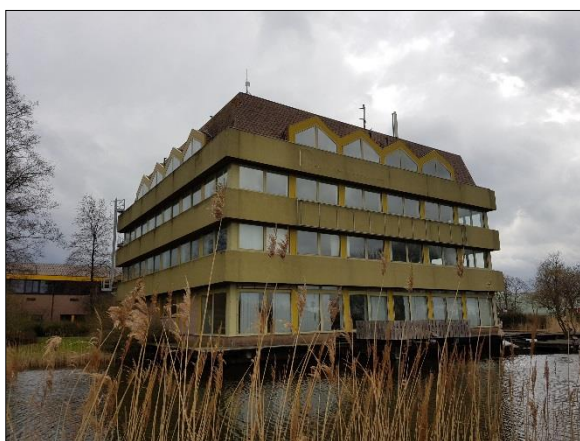
Figuur 3. Kantoorgebouw in westen plangebied
