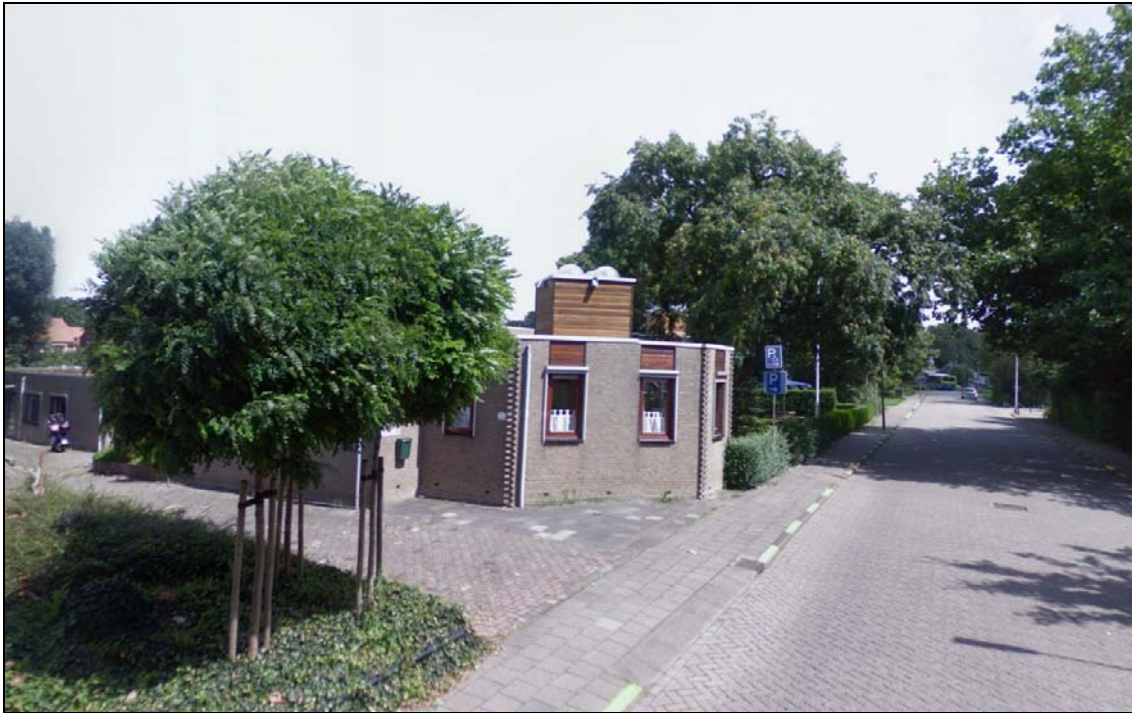
Afbeelding 2.2: Bestaande situatie vanaf de Ds. van Koetsveldstraat in oostelijke richting
