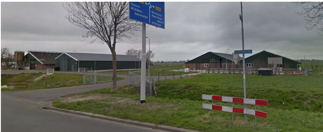
Afbeelding 2.1: foto huidige situatie bedrijfsgebouwen
