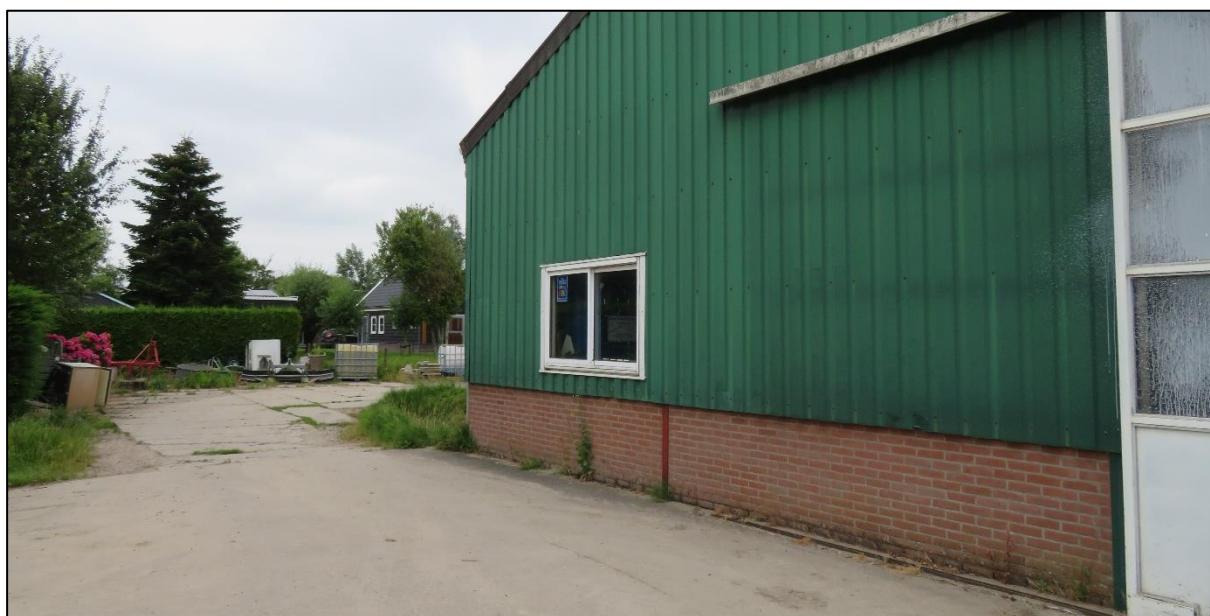
Afb 5: Deel van de bestaande schuur
