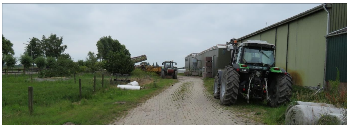
Afb 6: Zijgevel waartegen gebouwd gaat worden
