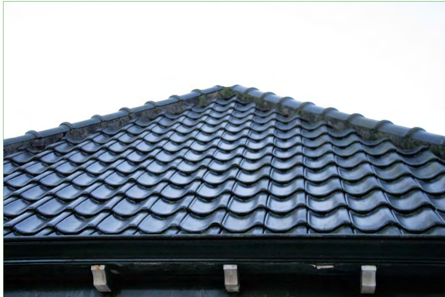
De dakpannen van het woonhuis sluiten nauw.
