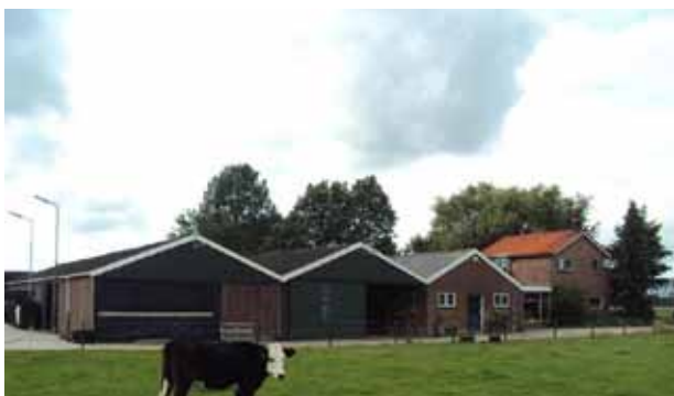
Bedrijfswoning voorop perceel, 3 schuren achter woning
