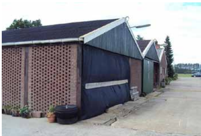
Drie aaneengeschakelde schuren
