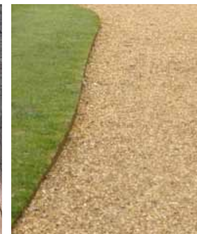
Referentie, oprit van halfverharding
