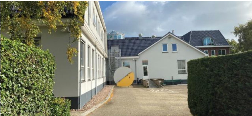
Figuur 2.3: Zicht op achtergevel vanaf binnenplein
