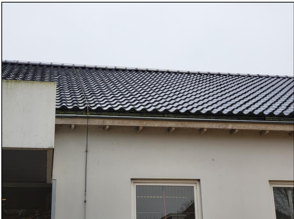
Figuur 4 Het dak waar dakkappen op worden gerealiseerd beschikt over vogelschroot welke strak aansluit. Het voorkomen van nestlocaties van de huismus kan derhalve uitgesloten worden.
