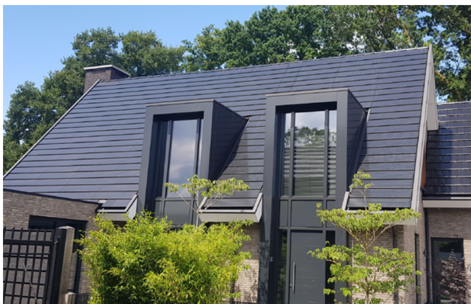
Afbeelding 19: Zonnepanelen verwerkt in dakbedekking
