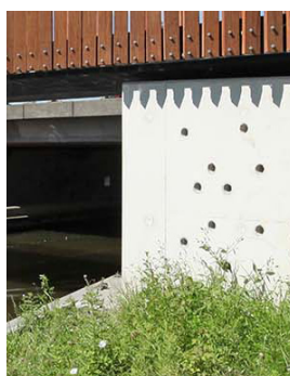
Referentiebeeld zwaluwgaten in brug
