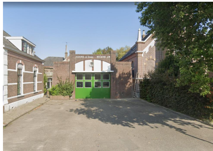
Figuur 7: Voorkant bebouwing Scharwoude 12
