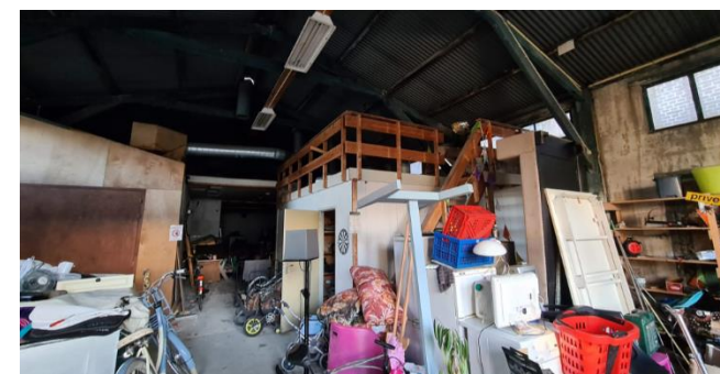
Figuur 9: Binnenkant van bebouwing aan Scharwoude 12
