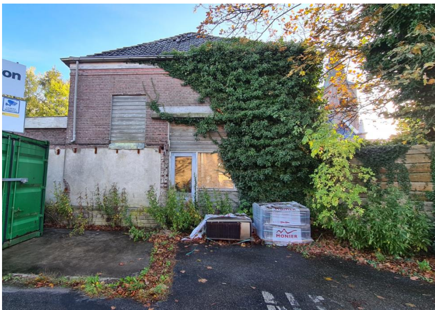
Figuur 6: Zijkant bebouwing Scharwoude 12
