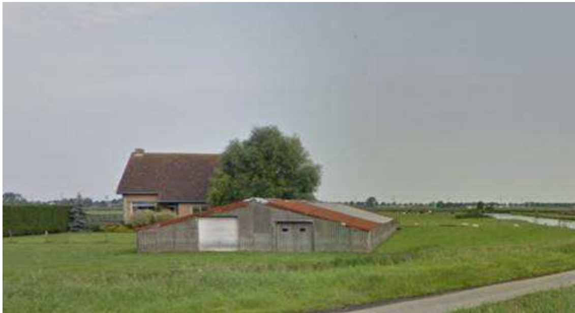
Figuur 2. Het erf aan de Oosteinde 4 te Berkhout met de deels te slopen schuur aan de voorzijde.
