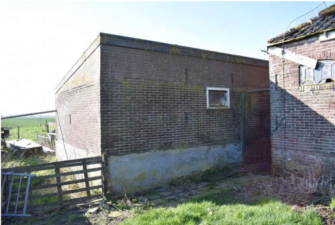
Boven Afb. 14 Varkensstal gebouwd in 1919 Onder Afb. 15 Varkensstal gebouwd in 1931
