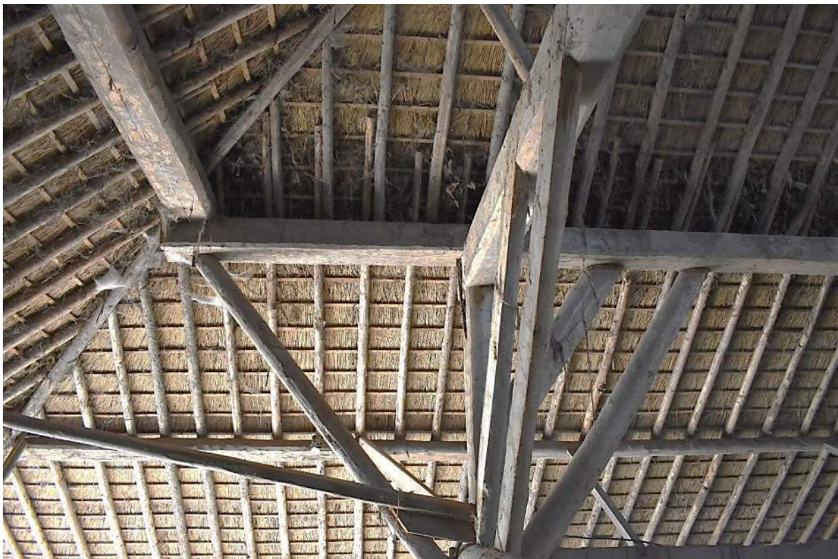
Afb. 20 Overstek vierkantconstructie schuur
