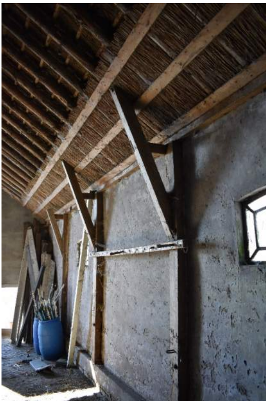
Boven Afb. 21 Vierkantstijl op gemetselde poer Onder Afb. 22 Dakconstructie dars met muurstijlen
