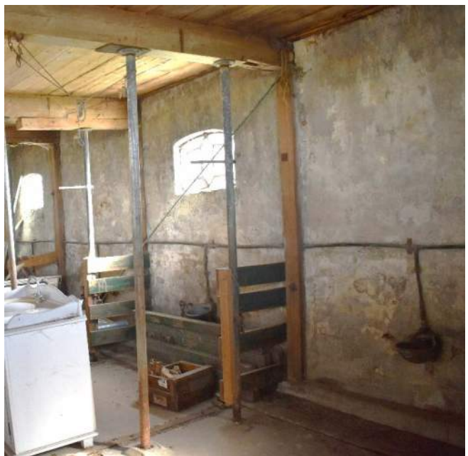
Boven Afb. 23 Ontmoeting stijl, dekbalk, bovenbalk en zwingen Onder Afb. 24 Gebinten lange regel
