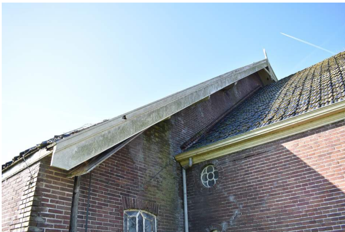
Afb. 36 Overgang voorhuis-stolpschuur / noordgevel
