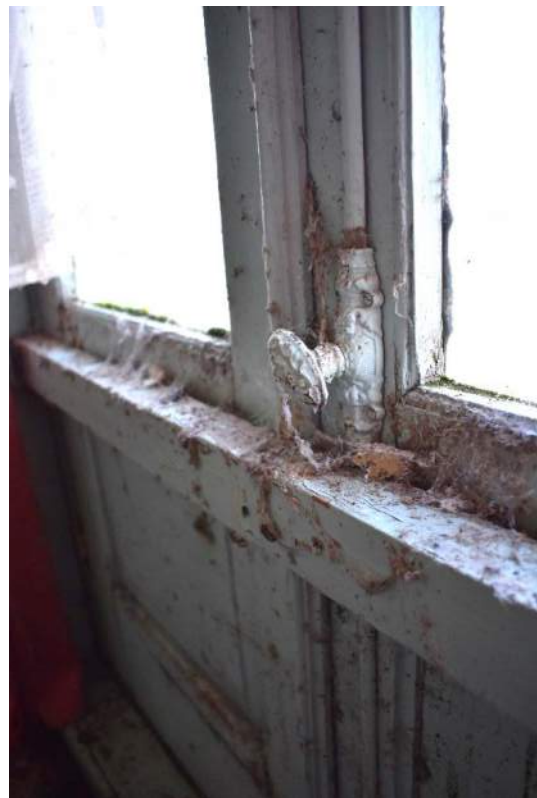
Rechtsonder Afb. 65 Origineel garnituur stolpdeuren
