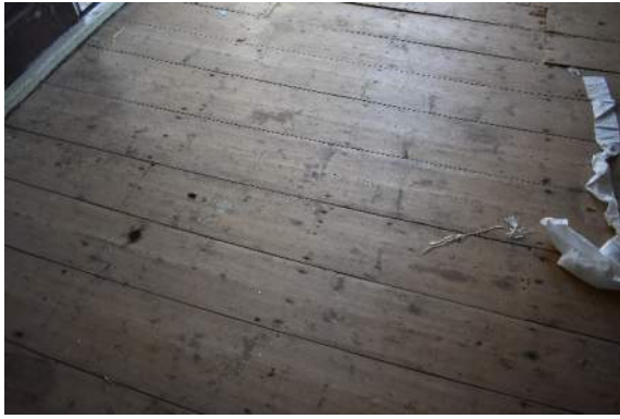
Afb. 18 Bestaande vloerdelen beganegrand voorhuis
