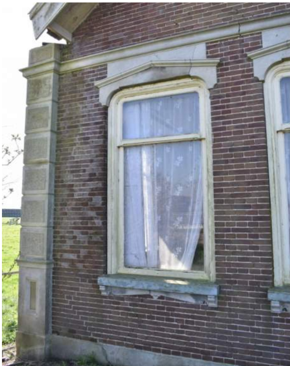
Afb. 26 Schuifvenster en hoekpilaster voorgevel
