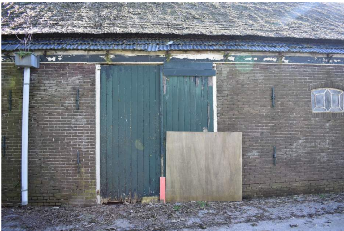
Afb. 39 Fragment westgevel stolpschuur
