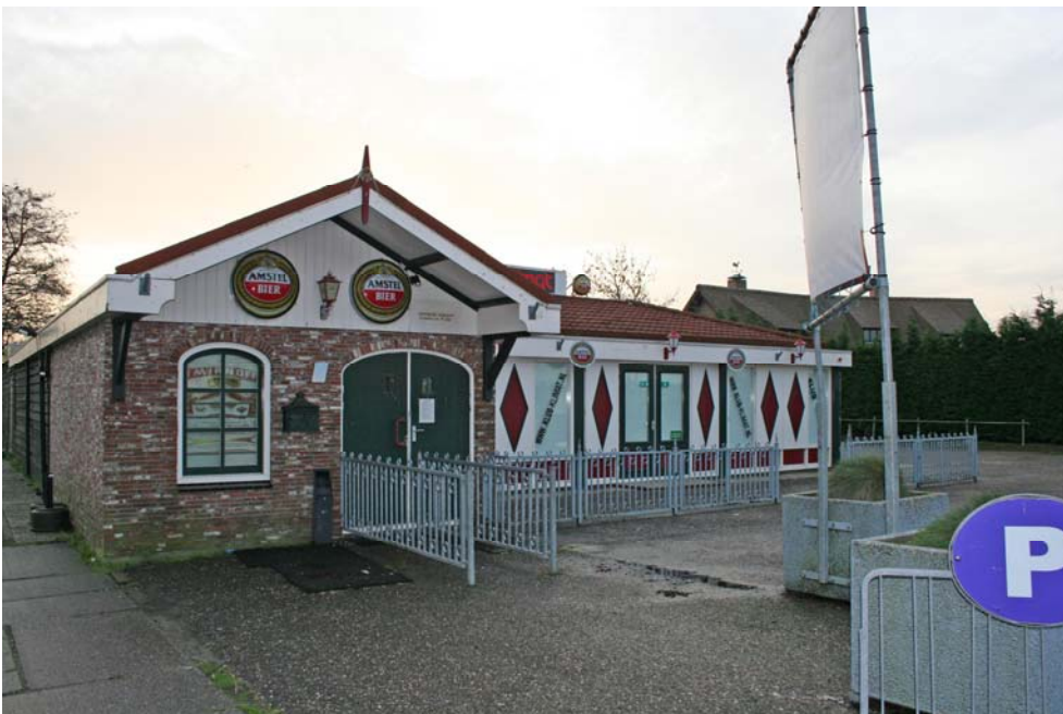
Figuur 2. Bestaande horeca-voorziening, te slopen bebouwing
