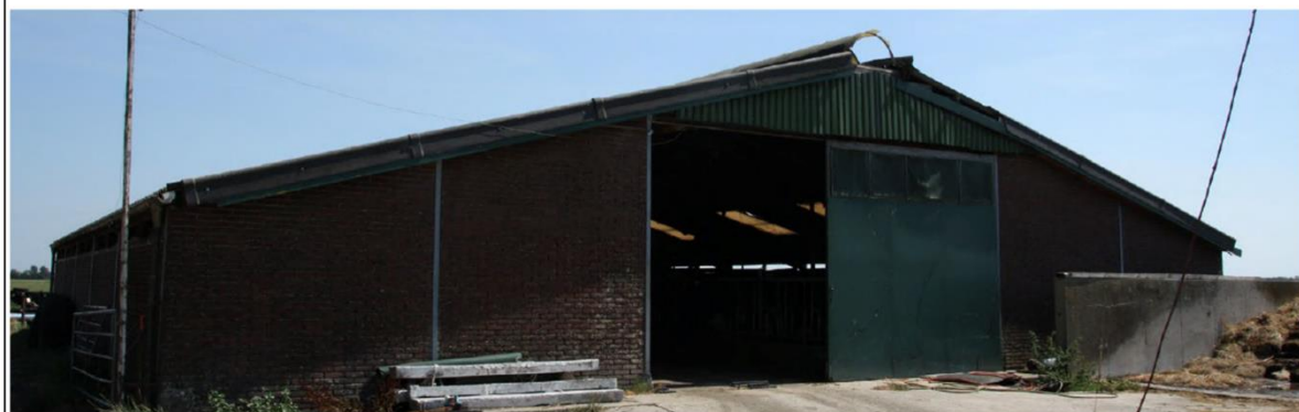
Stal ca. 380m 2 , muren baksteen en dak van plaatmateriaal.
